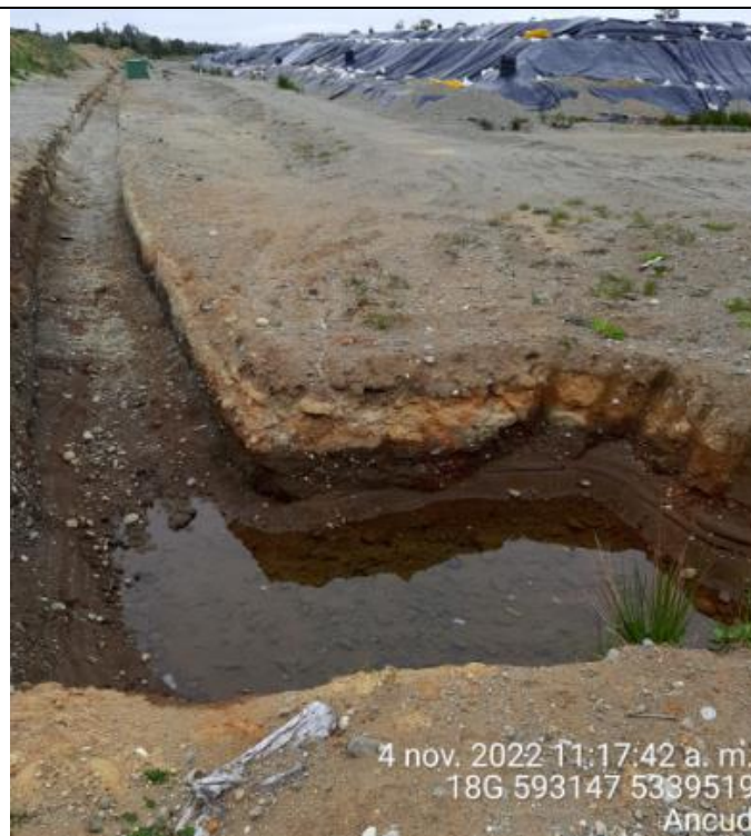
Fotografía N°31: Estado canales aguas lluvias
