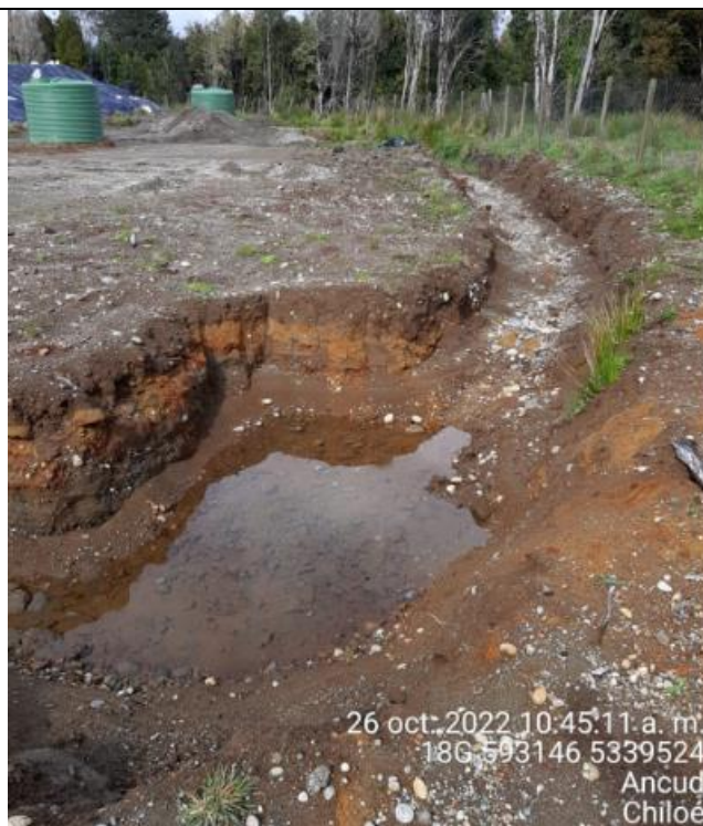
Fotografía N°25: Estado canales aguas lluvias
