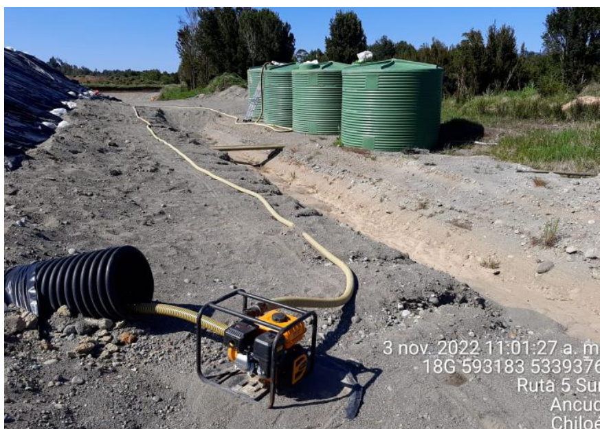
Fotografía N°9: Extracción de Lixiviados desde diagonal D02 por personal municipal. Tomada: Jueves 03 de noviembre del 2022.
