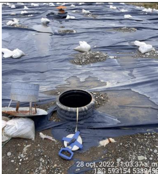
Fotografía N°17: Medición de Niveles de cámaras por Personal Municipal. Tomada: 28 de Octubre del 2022.
