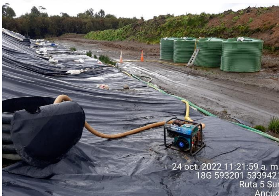
Fotografía N°2: Extracción de Lixiviados desde cámara C13. Tomada: Lunes 24 de Octubre del 2022.
