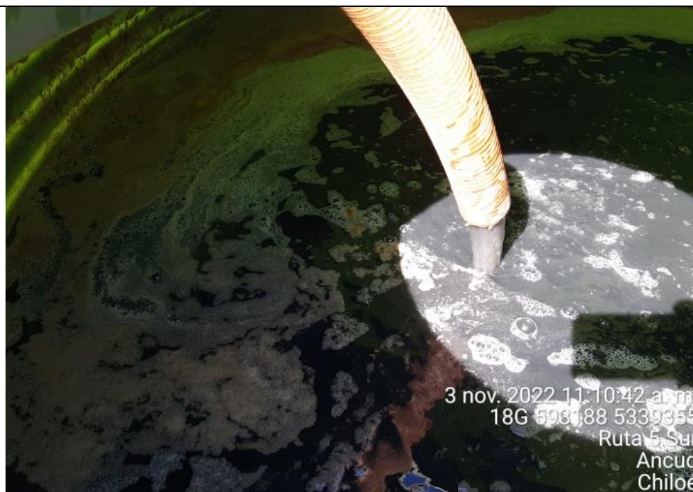
Fotografía N°10: Extracción de Lixiviados a estanque. Tomada: Jueves 03 de noviembre del 2022.
