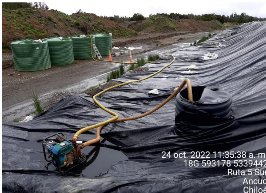
Fotografía N°1: Extracción de Lixiviados desde cámara C12. Tomada: Lunes 24 de Octubre del 2022.
