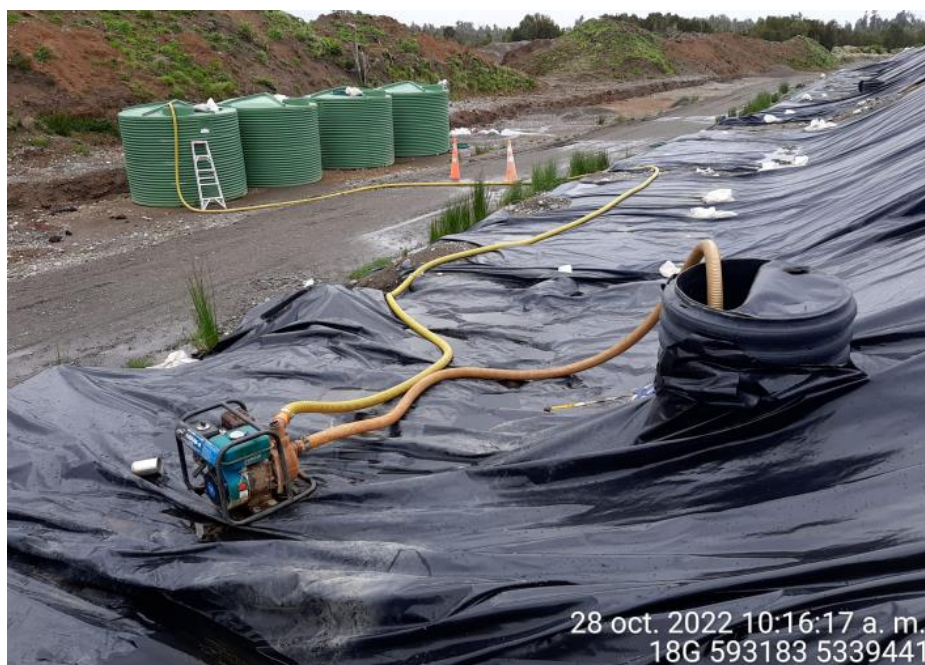
Fotografía N°6: Extracción de Lixiviados desde cámara C12 por personal municipal. Tomada: Viernes 28 de Octubre del 2022.
