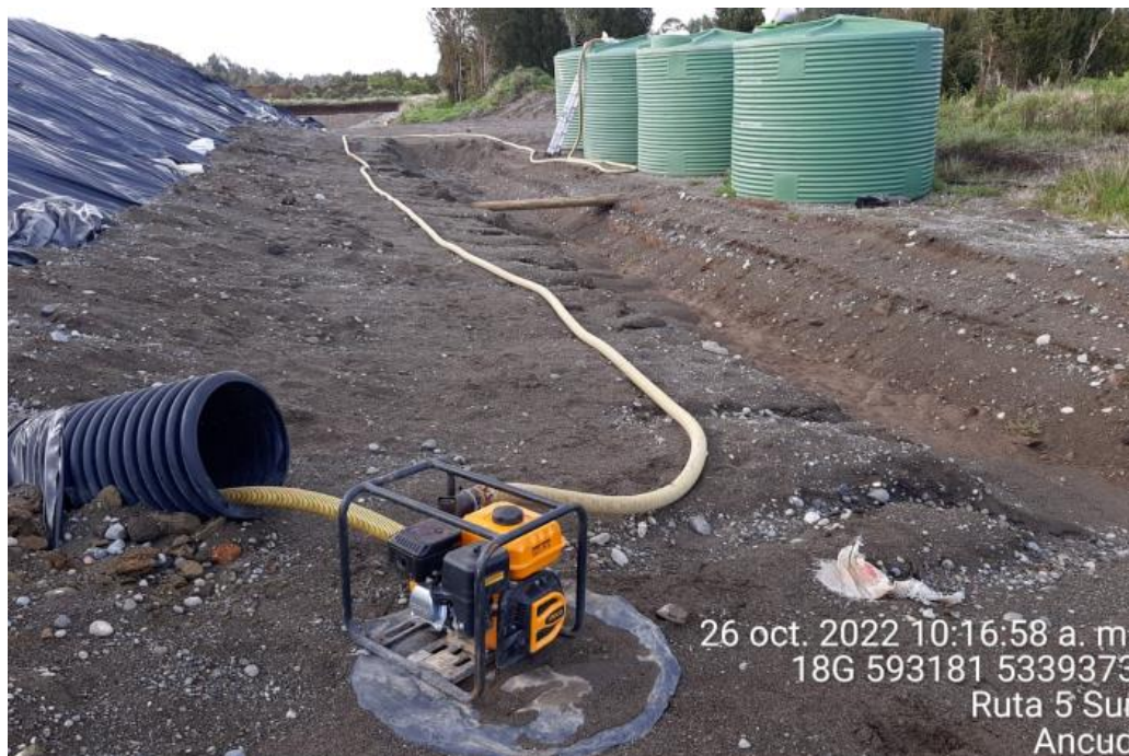
Fotografía N°4: Extracción de Lixiviados desde diagonal D02 por personal municipal. Tomada: Miércoles 26 de Octubre del 2022.
