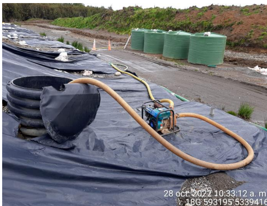
Fotografía N°7: Extracción de Lixiviados desde cámara C13 por personal municipal. Tomada: Viernes 28 de Octubre del 2022.
