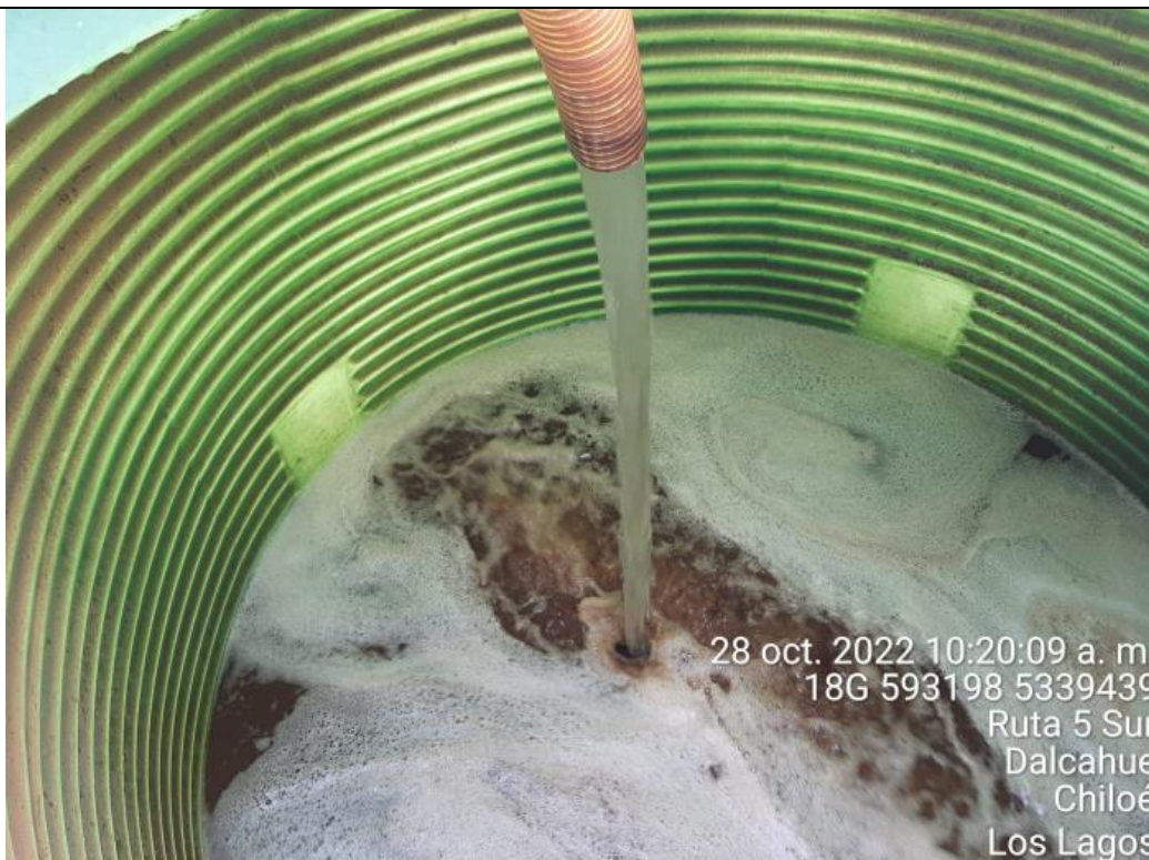
Fotografía N°8: Extracción de Lixiviados a estanque. Tomada: Viernes 28 de Octubre del 2022.
